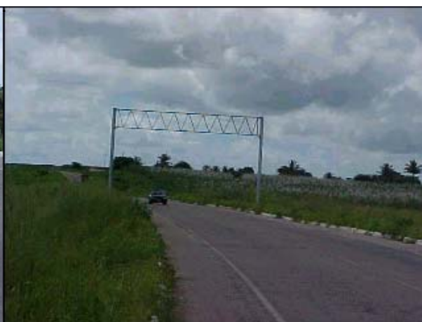
Figura AVP 24. Substituição dos pórticos com problemas de ferrugem
