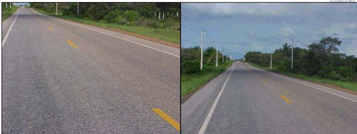
Figura AVP 43. Detalhe da capa de rolamento em boas condições
