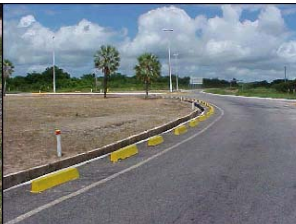
Figura AVP 20. Detalhe do trevo bem sinalizado
