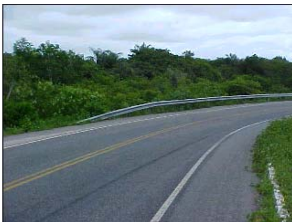
Figura AVP 47. Detalhe das defensas metálicas usadas como proteção nas curvas mais acentuadas
