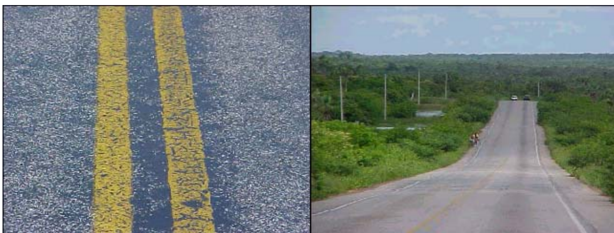
Figura AVP 21. Detalhe da capa do pavimento apresentando desgaste natural e pontos de exsudação
