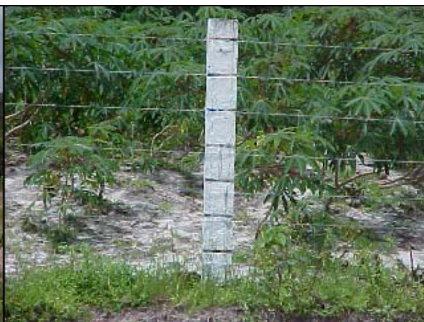
Figura AVP 34. Detalhe do cercamento da faixa de domínio. Mourões de concreto com oito linhas de arame
