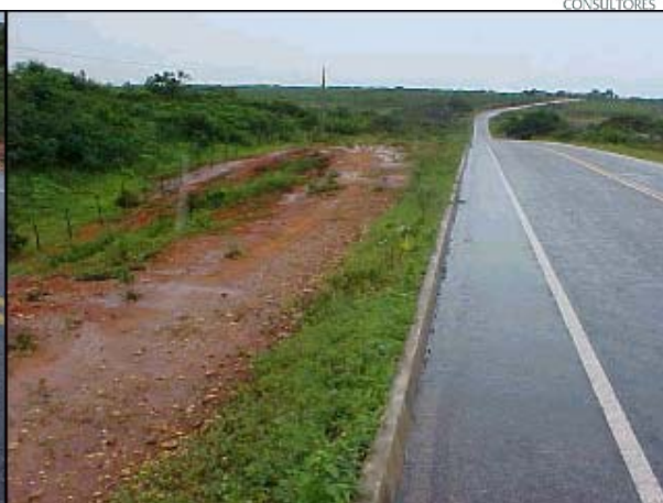
Figura AVP 46. Detalhe do dispositivo de drenagem, guia e sarjeta
