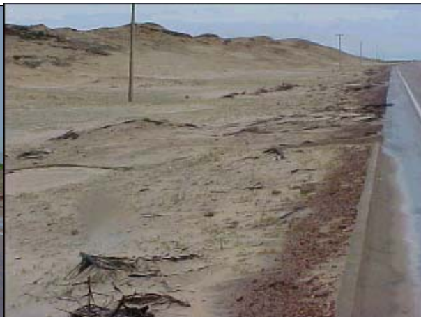
Figura AVP 52. Existência de dunas na margem da rodovia
