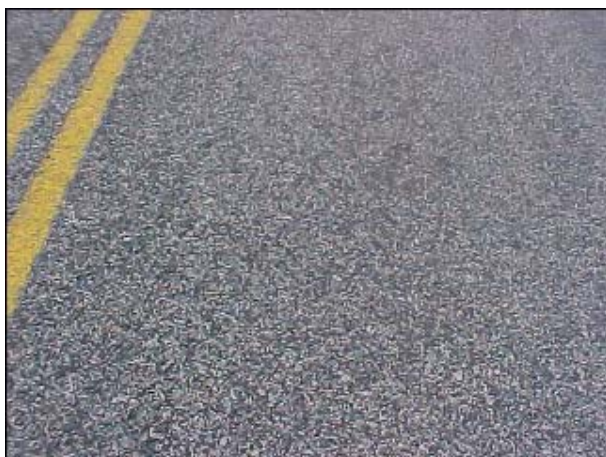
Figura AVP 25. Capa de rolamento em boas condições
