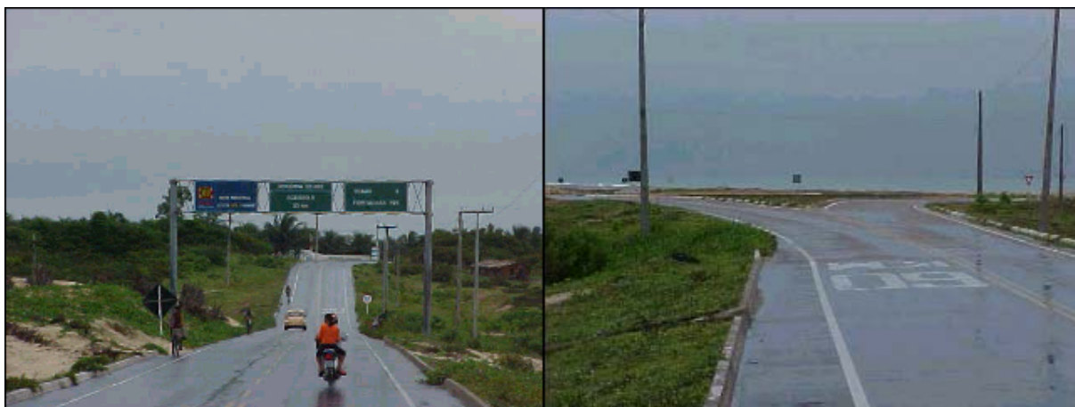
Figura AVP 49. Sinalização vertical com placas fixadas em pórticos
