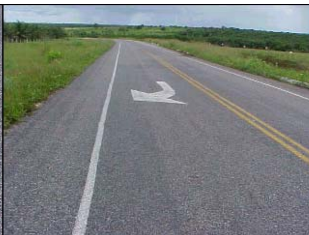
Figura AVP 26. Detalhe da sinalização horizontal, orientação de curva à frente
