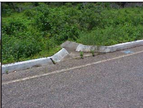
Figura AVP 30. Conjunto de dispositivos de drenagem
