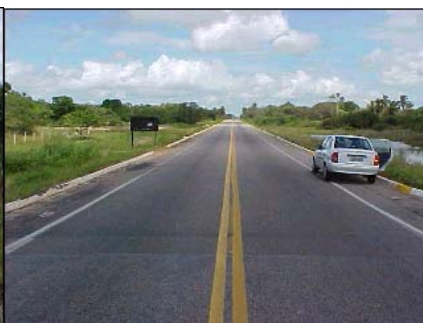
Figura AVP 18. Sinalização horizontal em boas condições
