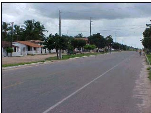
Figura AVP 31. Zona urbanizada. Existência de sonorizadores na entrada do vilarejo
