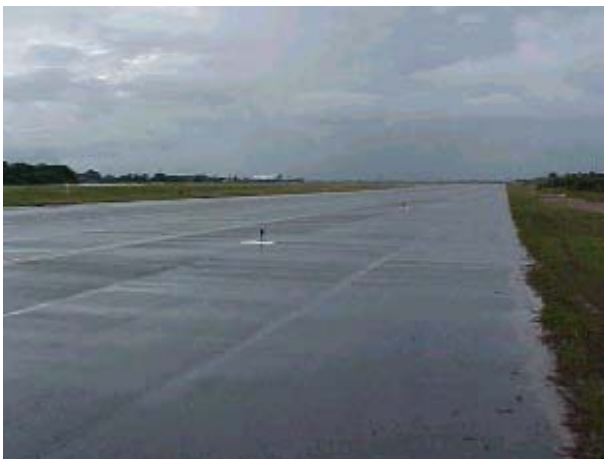
Figura AVP 58. Pista de táxi, em pavimento flexível
