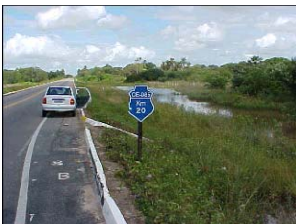
Figura AVP 17. Sinalização vertical em boas condições
