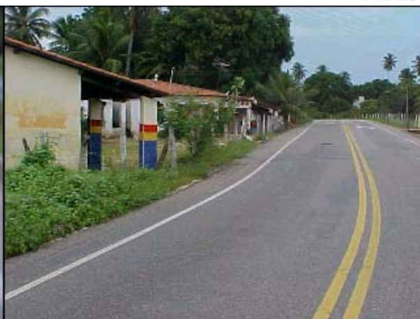
Figura AVP 54. Construções junto ao acostamento, situação de perigo para o usuário e para o morador
