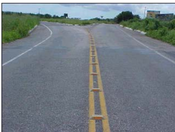
Figura AVP 27. Detalhe das taxas refletivas, orientação noturna na aproximação do trevo
