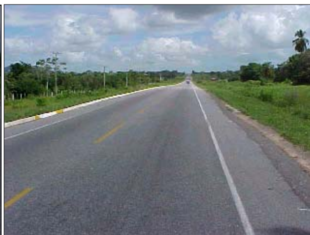
Figura AVP 16. Capa de rolamento em boas condições
