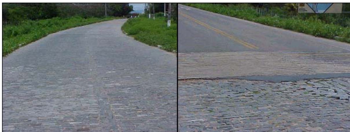
Figura AVP 37. Existência de trechos pavimentados em paralelepípedo antes das áreas urbanizadas
