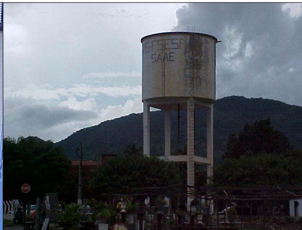
Figura DIB 29. Foto do reservatório elevado existente em Itapipoca
