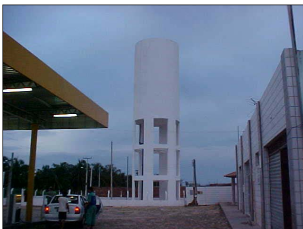
Figura DIB 23. Reservatório com 300 m³ de capacidade, executado com recursos do PRODETUR/CE I, em Trairi.
