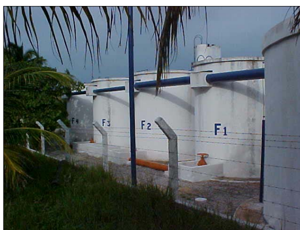
Figura DIB 16. Foto mostrando os filtros no local de captação de água bruta de Paracuru
