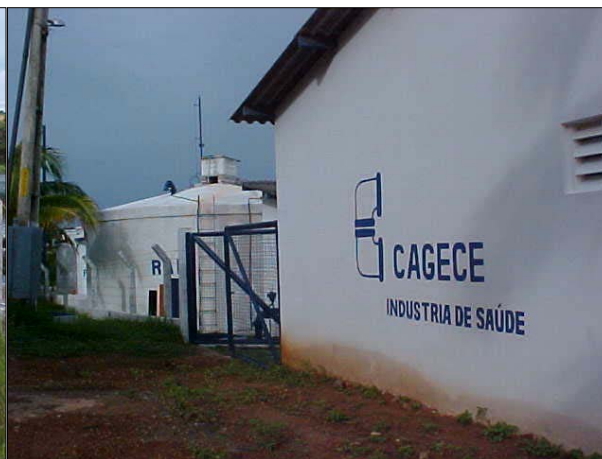
Figura DIB 15. Foto mostrando a elevatória de água tratada e reservatório de água de Paracuru
