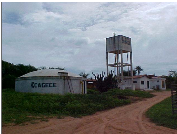
Figura DIB 31. Foto mostrando o sistema de reservação da localidade litorânea de Jericoacoara
