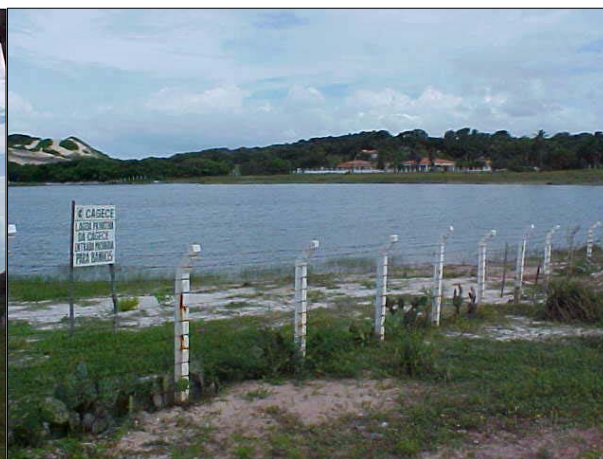
Figura DIB 09. Vista da lagoa da qual é feita a captação de água de Pecém
