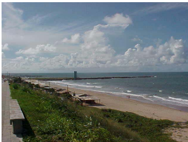
Figura DIB 38. Foto mostrando o local do emissário submarino de esgotos de Fortaleza
