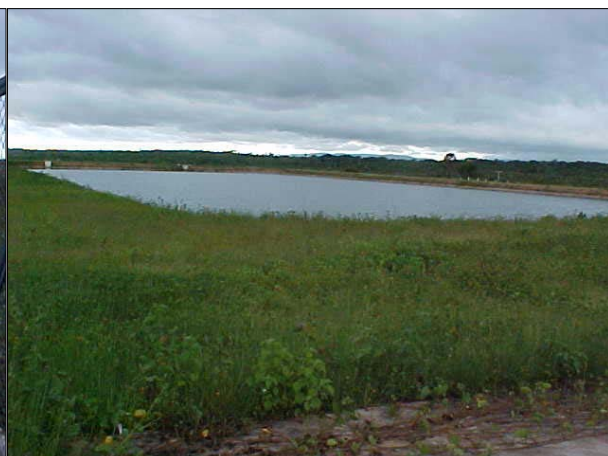
Figura DIB 47. Vista de uma das lagoas do sistema de tratamento de esgotos de São Gonçalo do Amarante
