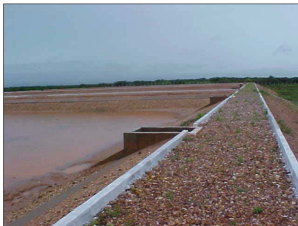
Figura DIB 52. Vista das instalações das lagoas do sistema de tratamento de esgotos de Lagoinha, em Paraipaba
