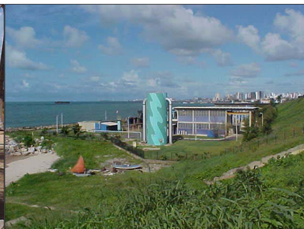
Figura DIB 41. Vista da elevatória e local de operação do pré-condicionamento de esgotos em Fortaleza
