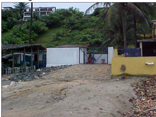
Figura DIB 48. Foto da elevatória de esgoto na Praia de Paracuru
