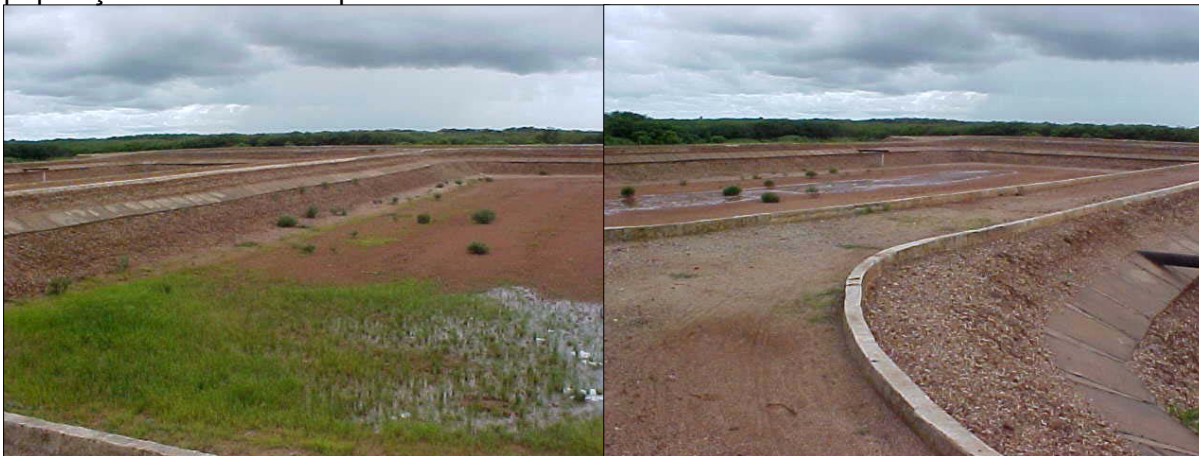
Figura DIB 53. Foto da lagoa de estabilização de esgoto de Jijoca do Jericoacoara
