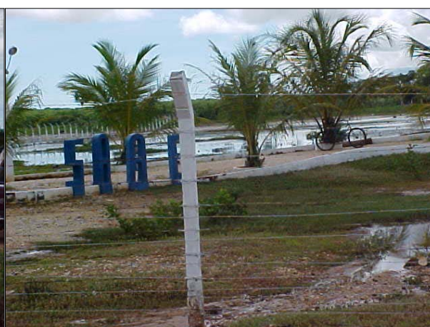
Figura DIB 58. Vista das lagoas de estabilização de esgoto de Camocim
