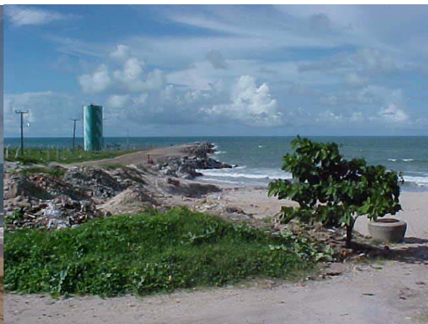
Figura DIB 39. Foto mostrando o lançamento do emissário submarino de Fortaleza
