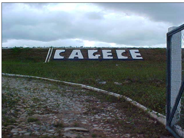
Figura DIB 46. Vista do local da operação do sistema de tratamento de esgotos de São Gonçalo do Amarante
