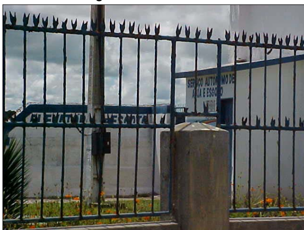
Figura DIB 55. Foto do prédio da elevatória de esgoto 1 de Camocim
