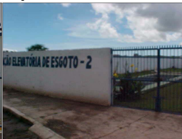
Figura DIB 56. Foto do local de instalação da elevatória de esgoto 2 de Camocim
