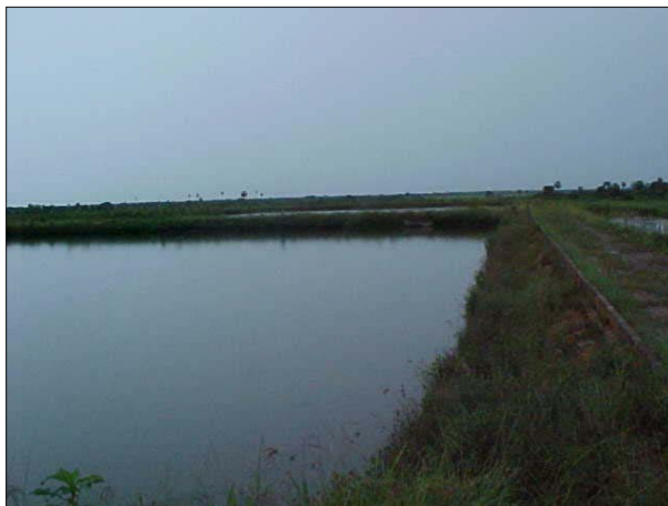
Figura DIB 50. Vista das lagoas do sistema de tratamento de esgotos da sede de Paraipaba
