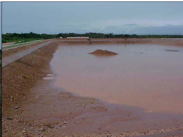
Figura DIB 51. Vista das lagoas, em fase final de implantação, do sistema de esgotos de Lagoinha, em Paraipaba
