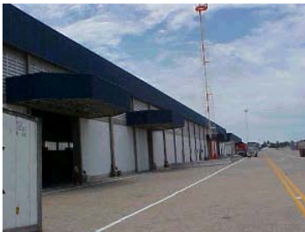
Figura TRA 38. Vista frontal da área de armazéns
