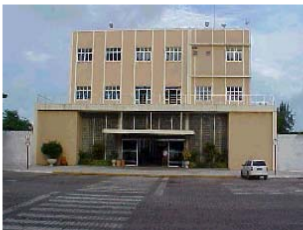
Figura TRA 29. Vista externa do edifício que abriga o terminal de passageiros (pavimento inferior) e a administração do Porto de Mucuripe (pavimento superior)
