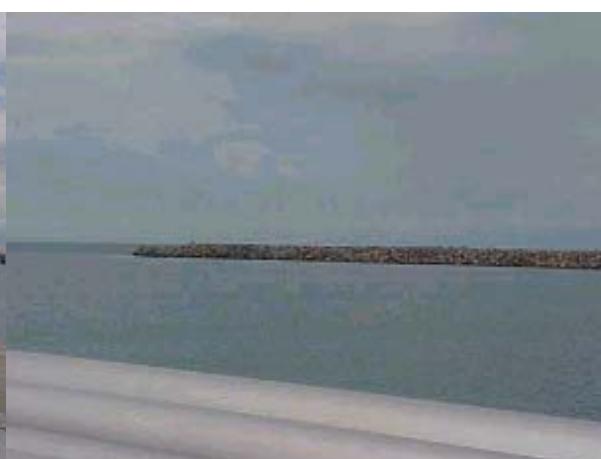
Figura TRA 37 Vista geral do quebra-mar. Estrutura em enrocamento
