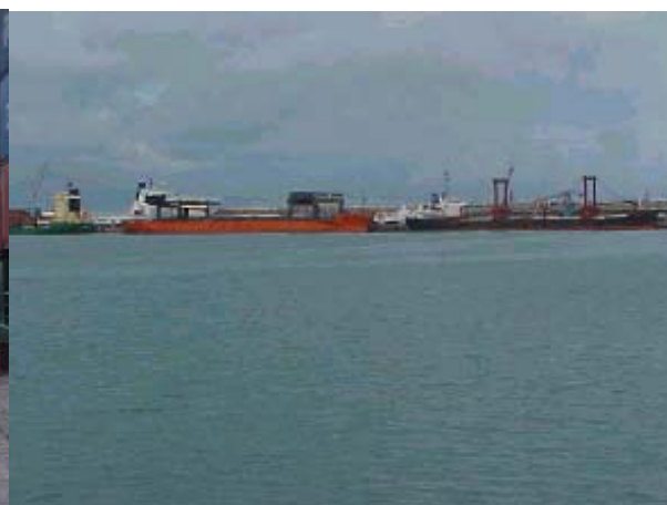
Figura TRA 32. Vista geral do cais
