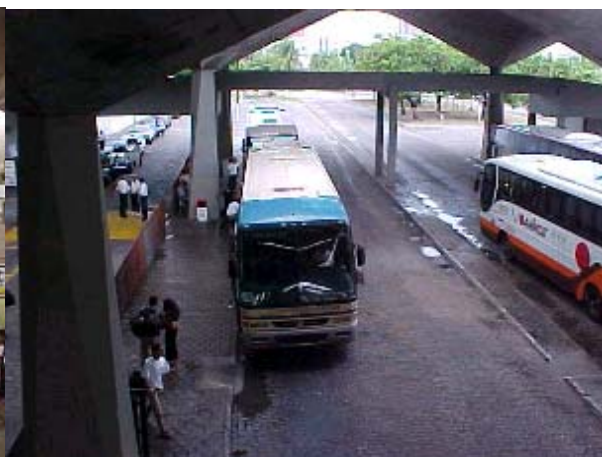
Figura TRA 41. Detalhe das plataformas de embarque
