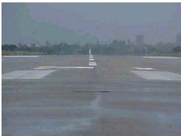
Figura TRA 20. Detalhe da pista de pouso principal
