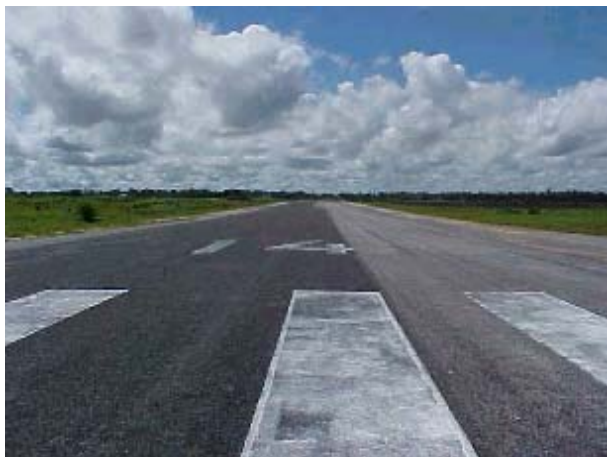
Figura TRA 27. Pista de Pouso, Detalhe da Cabeceira 14
