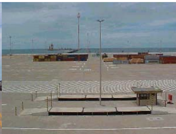
Figura TRA 39. Pátio de armazenagem. Detalhe da balança de carga
