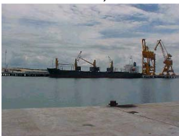
Figura TRA 36. Vista geral do pier 02 – carga de granéis líquidos e gases liquefeitos
