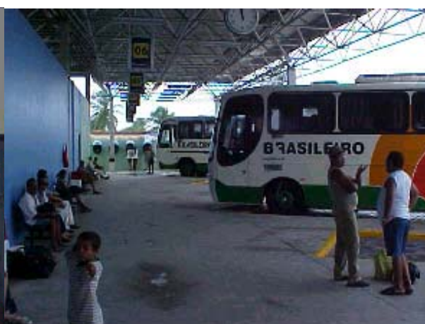
Figura TRA 47. Detalhe das plataformas de embarque
