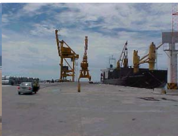
Figura TRA 35. Pier 01 – Carga de produtos siderúrgicos e carga geral
