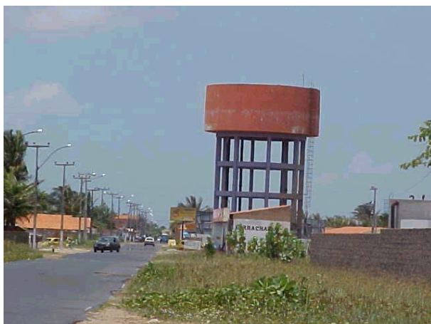
Figura DIB 05. Foto do conjunto de reservação de Luís Correia
