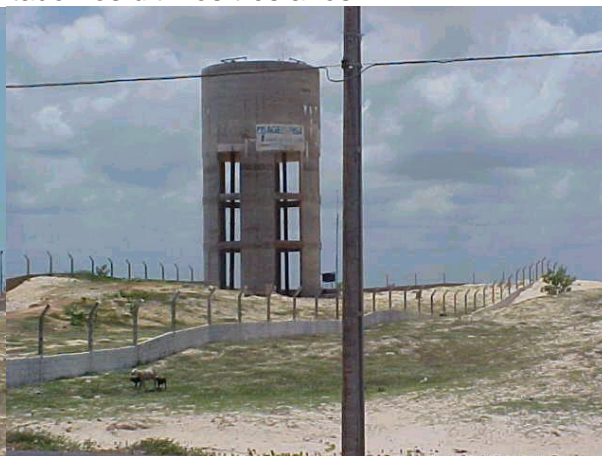
Figura DIB 04. Foto do reservatório II de distribuição de água de Luís Correia
