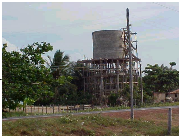
Figura DIB 22. Foto do reservatório em construção na Ilha Grande
