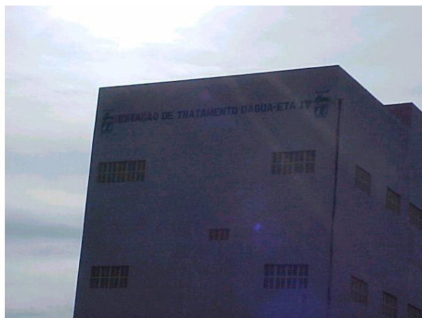
Figura DIB 11. Foto do prédio da estação de tratamento de água ETA-IV de Parnaíba
