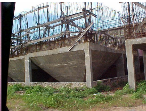
Figura DIB 14. Foto das obras de ampliação da ETA-IV, que foram paralisadas
