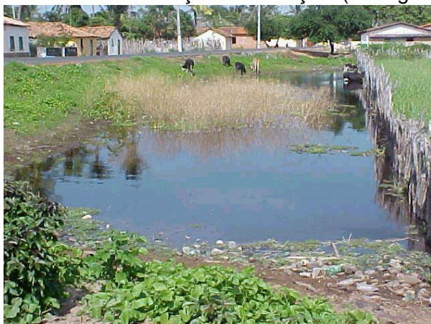
Figura DIB 24. Foto de depressão com empocamento de água, na cidade de Ilha Grande
