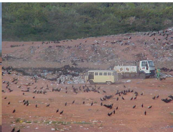
Figura DIB 28. Vista da operação de descarga de resíduos do aterro sanitário de Teresina
