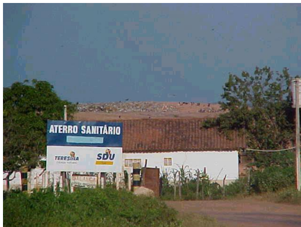
Figura DIB 26. Vista do acesso ao aterro sanitário de Teresina
