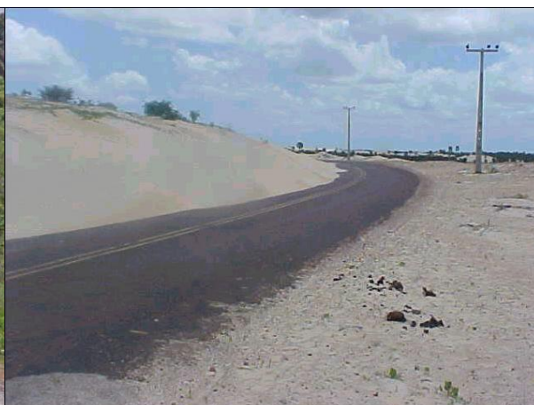
Figura DAT 24. PI-116, duna invadindo metade da pista de rolamento
