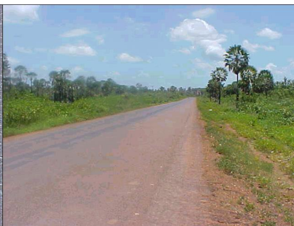
Figura DAT 38. PI – 213 – Detalhes da ausência da sinalização horizontal
