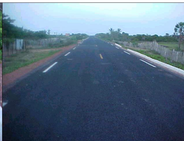
Figura DAT 32. Ligação Ilha Grande – PI – 116 ( 7km. Pedra do Sal ), detalhe de guia e sarjeta
