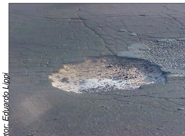
Figura DAT 33. PI – 210 / BR - 402, trecho deteriorado com muitos buracos
