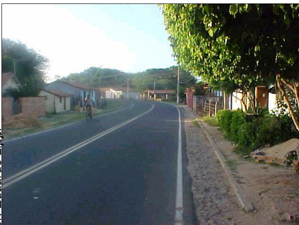
Figura DAT 21. PI-116, trecho com iluminação pública e acostamento pavimentado
