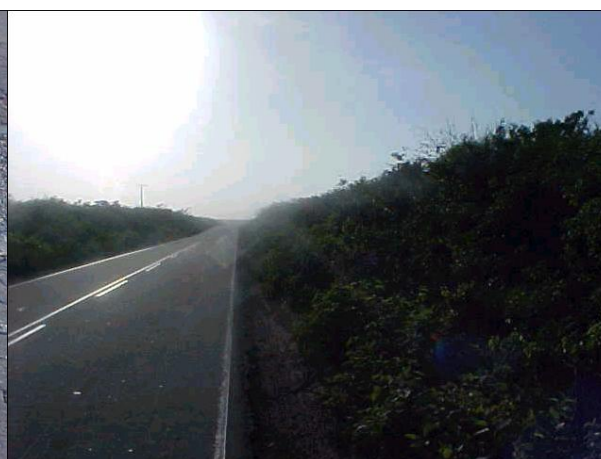
Figura DAT 34. PI – 210 / BR - 402, vegetação densa invadindo a área do acostamento
