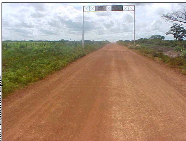
Figura DAT 39. PI – 213, estrada cascalhada em boas condições
