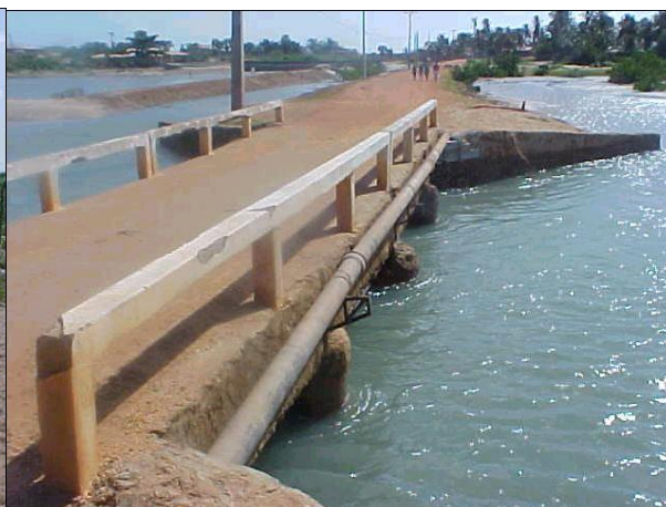
Figura DAT 26. Ligeação Cajueiro da Praia – Barra Grande, ponte estreita de concreto
