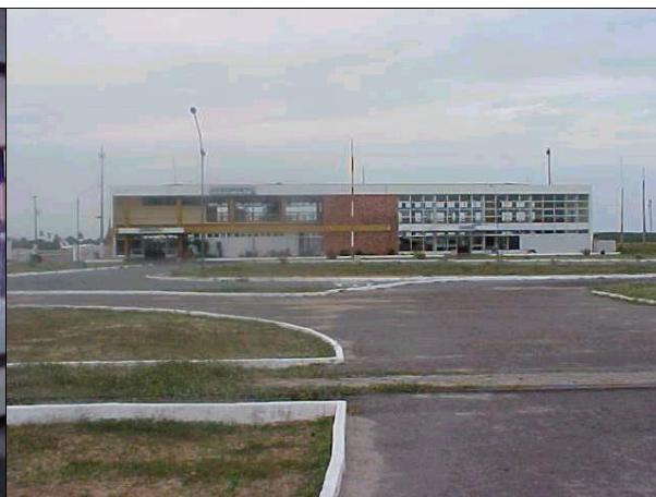
Figura DAT 49. Vista frontal do terminal de passageiro e estacionamento de veículos.
