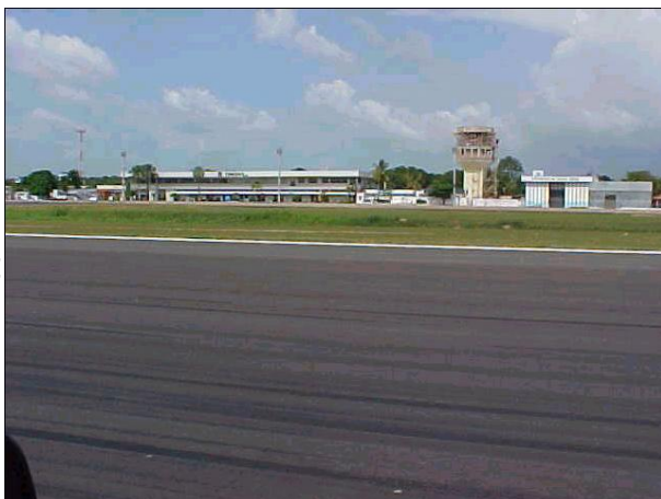
Figura DAT 43. Vista frontal do Terminal de passageiros e a torre de controle que está sendo construída
