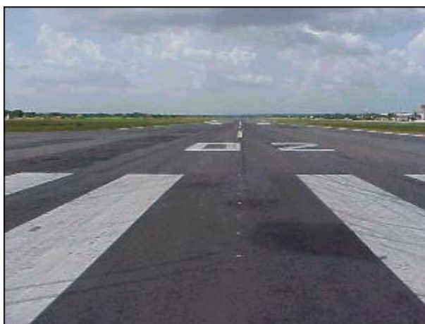
Figura DAT 41. Pista de pouso, em pavimento asfáltico
