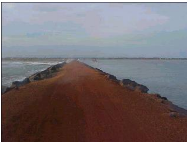
Figura DAT 50. Porto de Luís Correia, detalhe do mole em enrocamento
